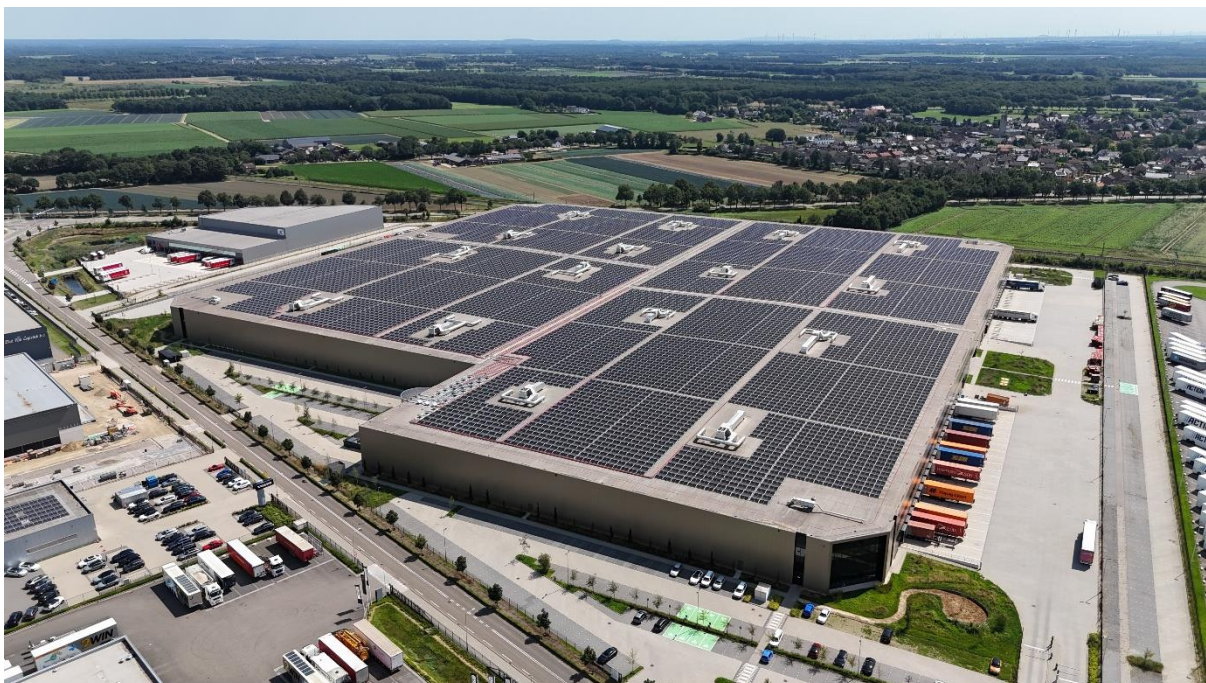
Légende : Centrale photovoltaïque Sunrock sur bâtiment logistique Crédit photo : Sunrock
